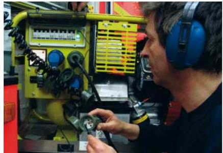
Überprüfung der Schutzmaßnahme eines tragbaren Stromerzeugers
